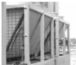
Технология позволяет автоматически оценивать степень замораживания в соответствии с температурой окружающей среды и фактическими рабочими параметрами установки. Исключено образование наледи в поддоне за счет увеличения расстояния между теплообменником и поддоном для отвода конденсата.
